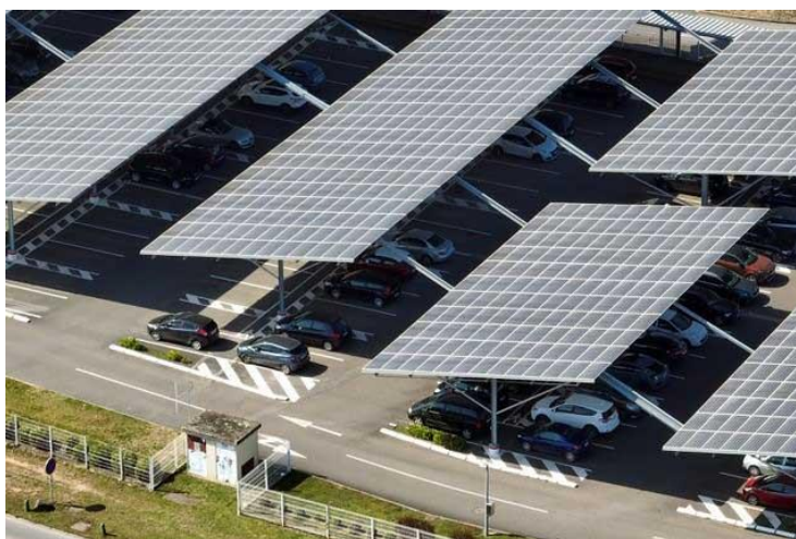
Слика 24. Фотоволтаични панели со потребната конструкција над паркинг
